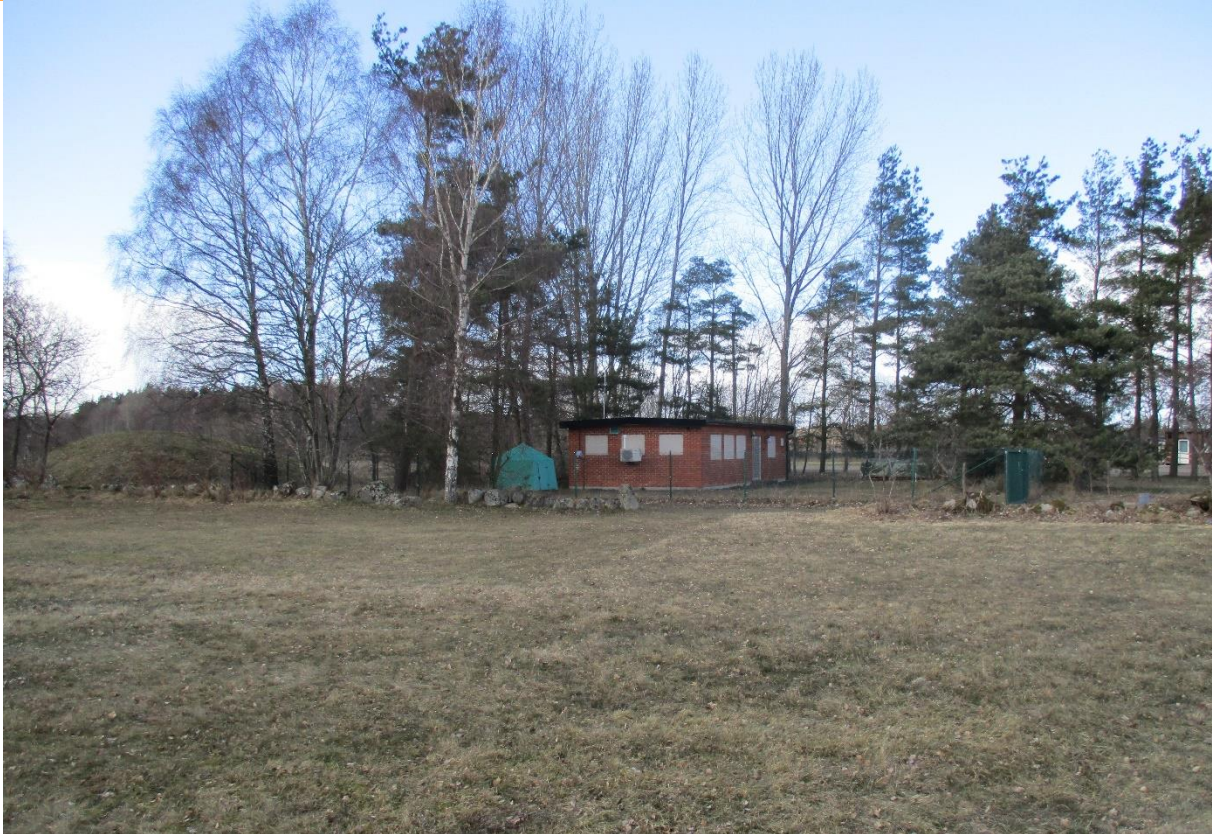
Befintlig vattenverksbyggnad och pumpstation.
