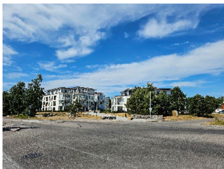
Byggnation på fastigheten
