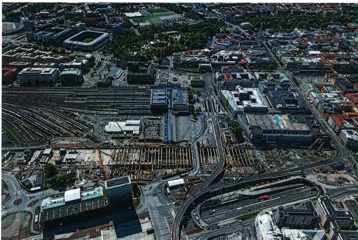
Figur 3: Foto över pågående byggnation inom planområdet (Göteborg stad 2023)
