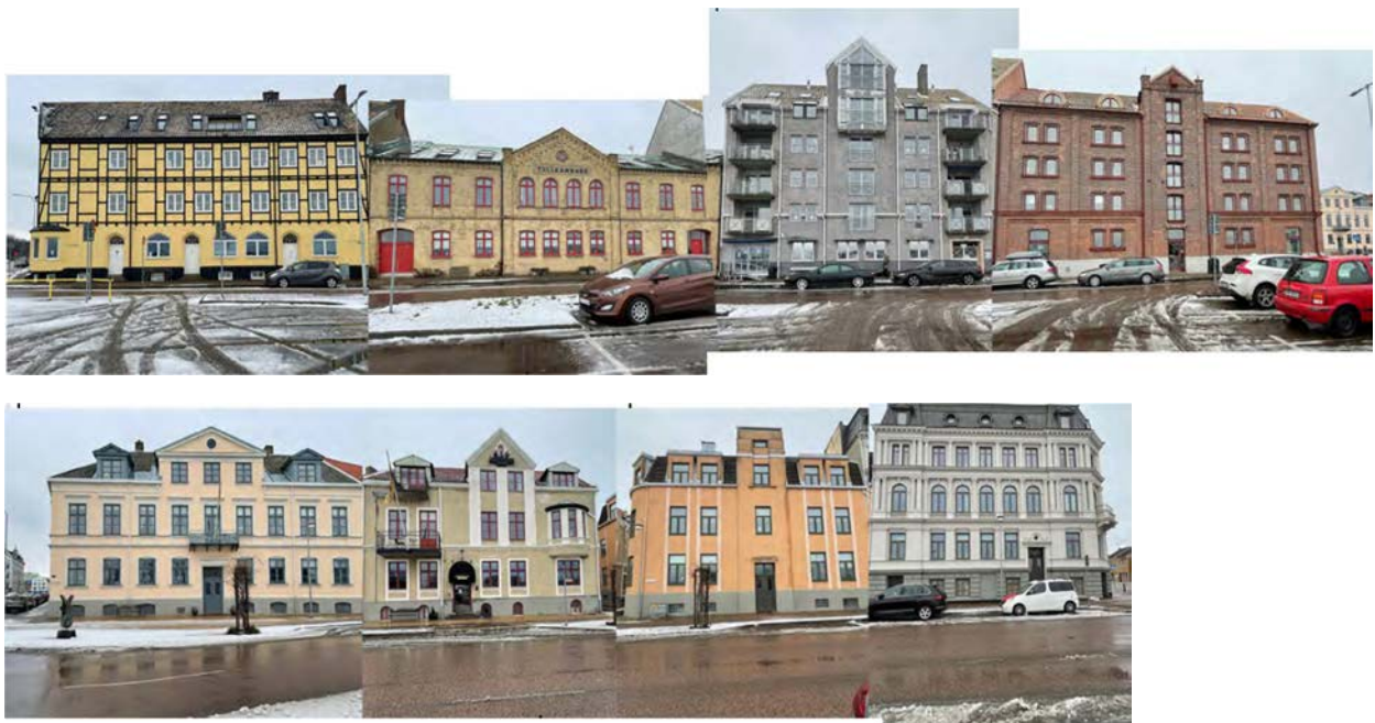
Bildsammanställning av fasader mot Skeppsbrokajen. Flertalet uppförda mellan 1850-1880 med tidstypisk arkitektur. Övre bildraden visar bebyggelse från Hamngatan till Kungsgatan och undre bilden visar från Kungsgatan till Storgatan. Bilder: Jais Arkitekter
