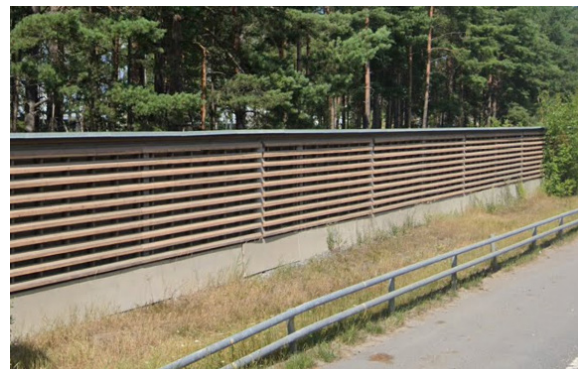
Horisontell spaltpanel som bullerdämpare vid väg.
