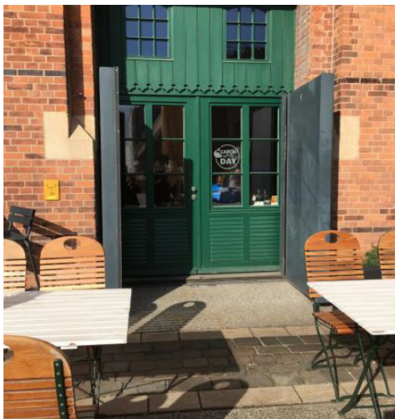
Avstängningsbar port till lokal. Exempel från Hamburg. Bild: Sweco
