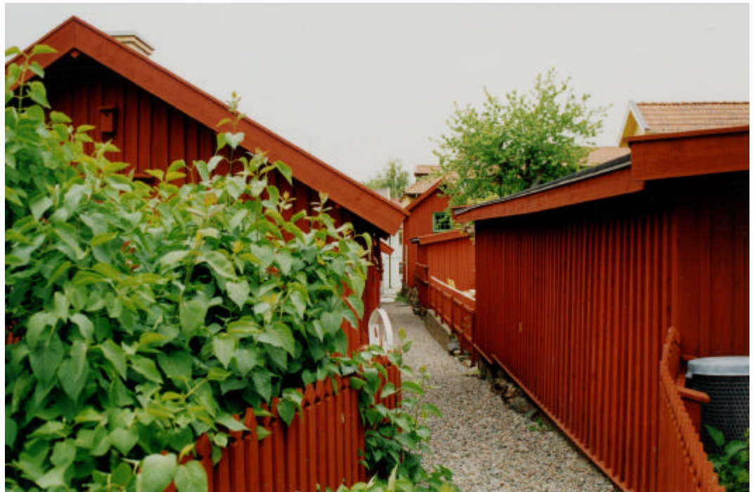
Den renoverade slaskgatan i kvarteret Frigga sedd från söder
