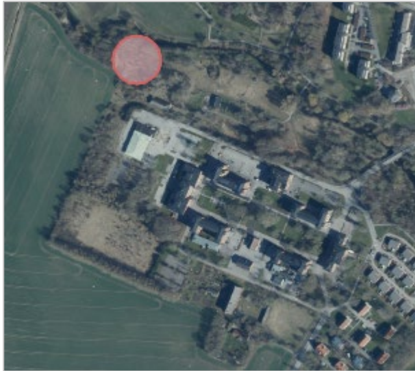
Område där avfall påträffats
