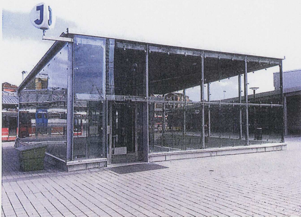
Den glasade entrén till tunneln under järnvägen, tillika entré till tågstationen
