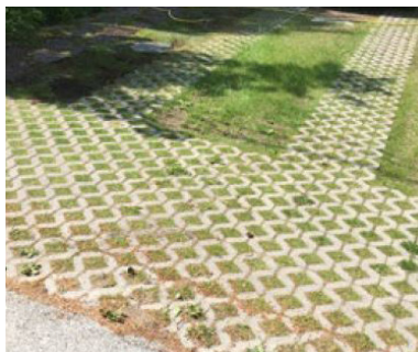
Exempel från Järfälla på genomsläpplig markbeläggning för biluppställning på kvartersmark
