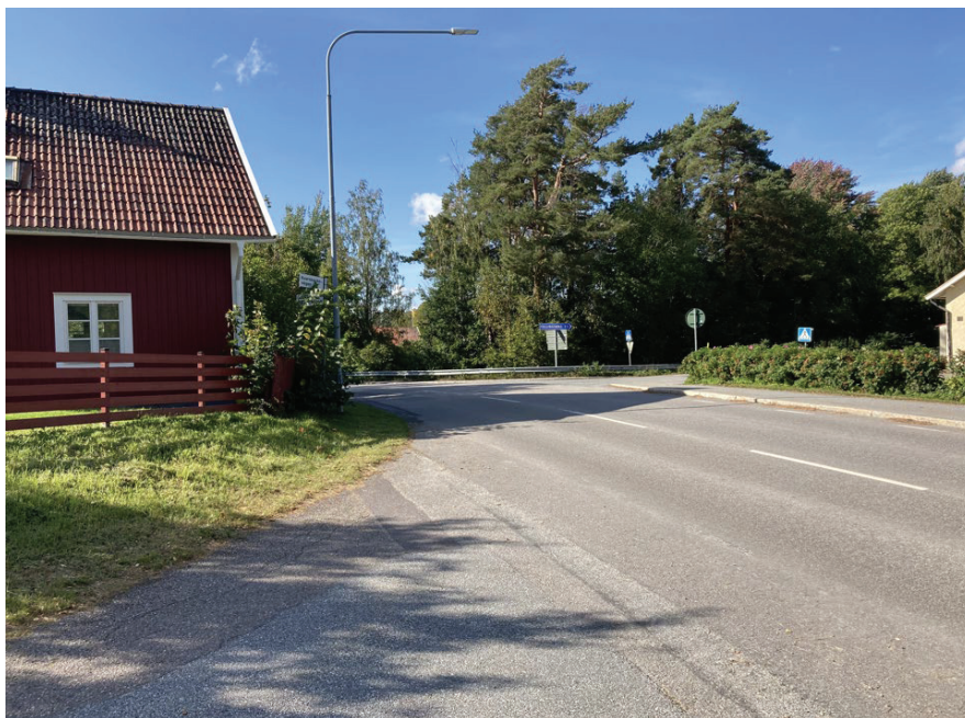
Vy västerut vid korsningen Kvarnbackevägen/Gamla Arbogavägen. Sikten är blockerad och korsningen bedöms som ett sämre alternativ än att använda befintlig utfart direkt till Gamla Arbogavägen.
