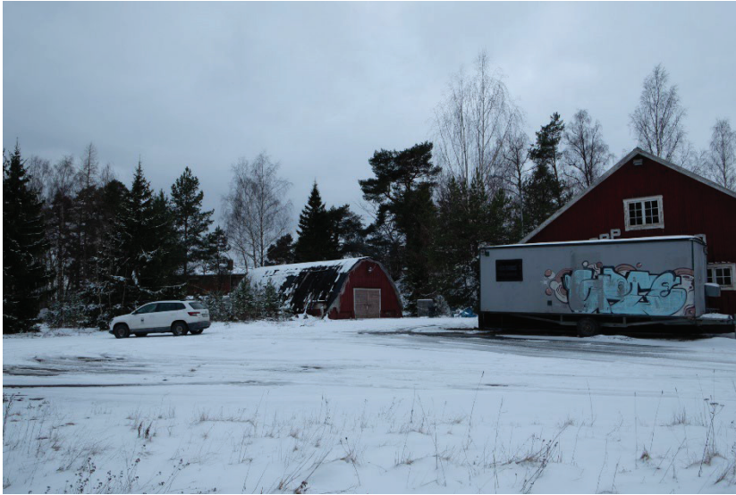
Planområdet sett från infarten vid Gamla Arbogavägen. Perspektiv mot sydväst. Loppisbyggnaden från föregående två bilder till höger i bild. Till vänster syns även en övergiven hangarliknande byggnad med okänd tidigare användning.
