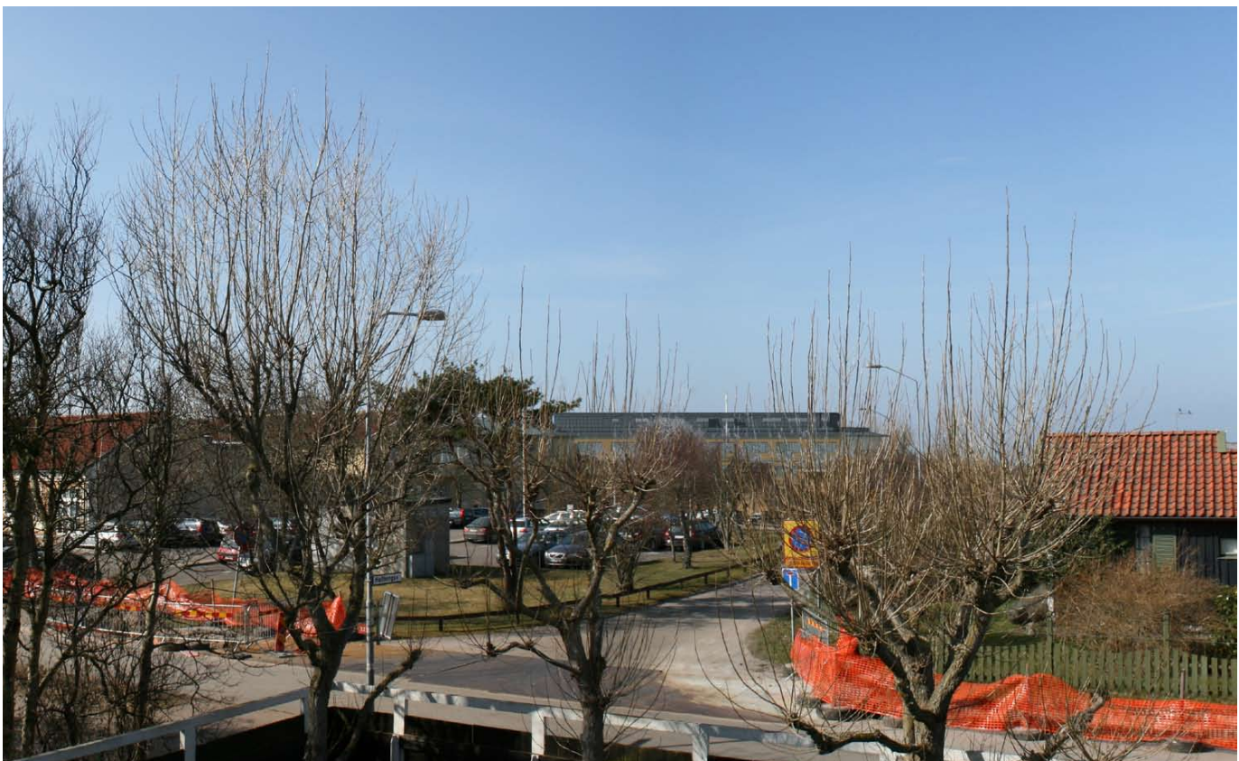
Vy från Älgvägen 14 efter ombyggnad.
