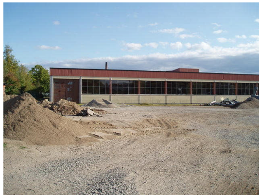
De ytor som inte är bebyggda utgörs främst av plana, grusade ytor.
