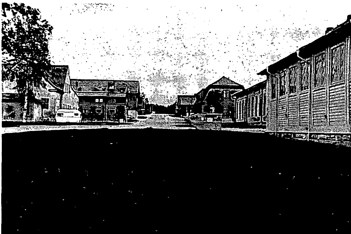
Interngatan mellan det äldsta kasernområdet från 1895, till höger och det mellan 1919 och 1939 tillbyggda kasernområdet till vänster. Gatan går från de västra till de östra delarna av A4 området och leder vidare i tunnel till ATC-området. Den utgör både gräns mellan två kasernområden med olika karaktär och är ett viktigt förbindelsestråk inom området.
