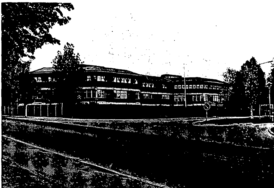
Militärrestaurangen ovanför A4-grinden vid Biblioteksgatan. Invigd 1983, ritad av FFNS Arkitekter i Östersund.
