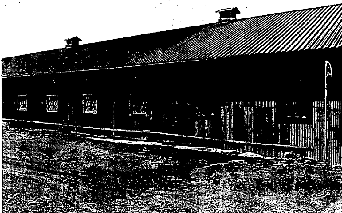
Förråd (14), 1894, baksidan mot öster.
