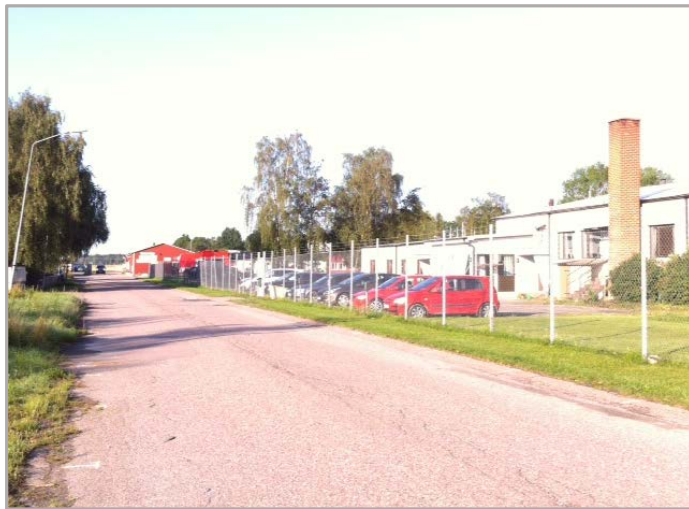
Industrivägens norra del mot fastigheten Rymningen 15:35.
