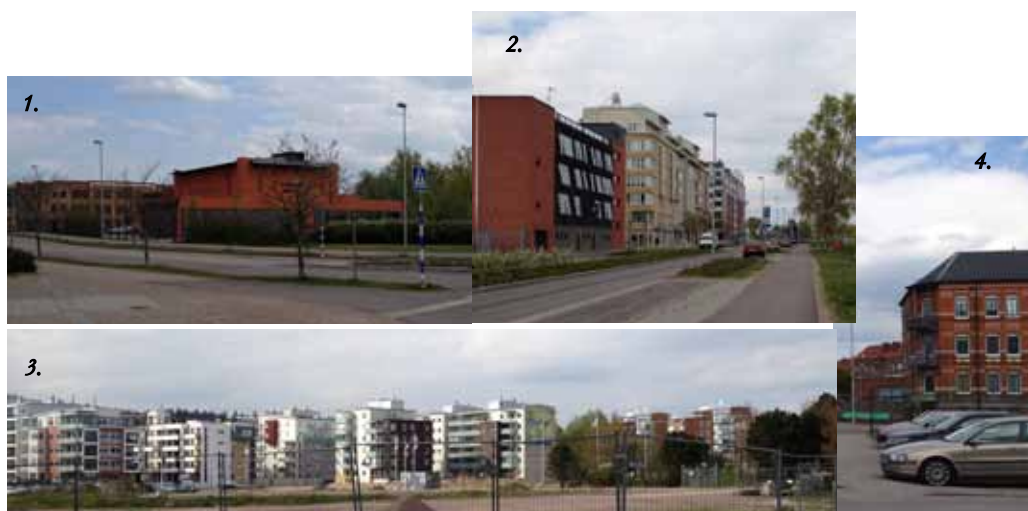
Fig 5, 1: HEM's tekniska anläggning, 2: Angränsande bebyggelse Gamletullsgatan, 3: Gamletull-/Nissastrandsområdet, 4: angränsande bebyggelse i söder längs med Gamletullsgatan.
