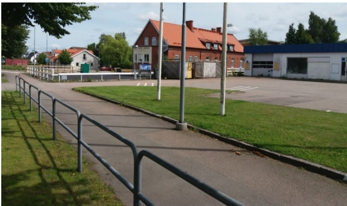
Planområdet med vy åt sydöst. Gång- och cykelvägen löper direkt norr om planområdet.
