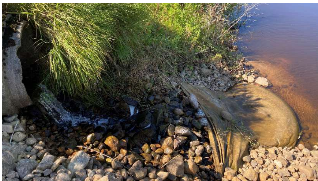
Figur 5. Erosionsskydd med vattenfylld "kudde" under geotextilen.
