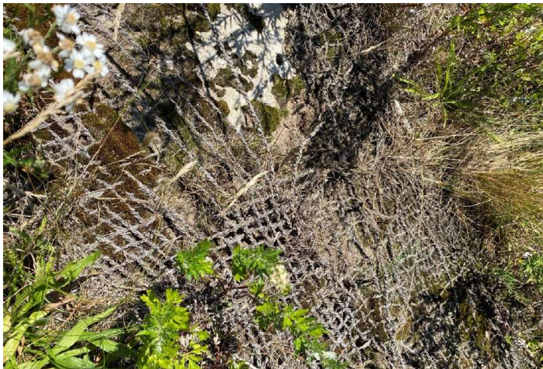
Figur 35, Erosionsskydd, kokosmatta samt underliggande duk.
