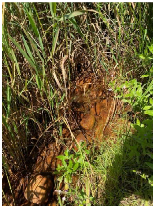
Figur 28, Järnutfällningar i utloppsdike.
