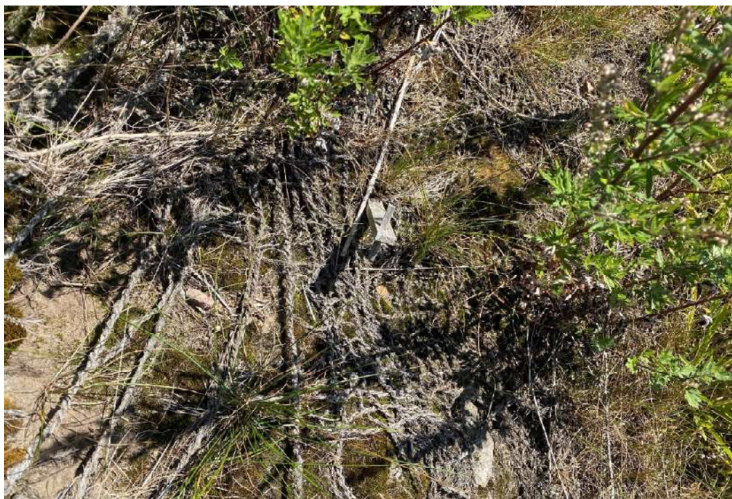
Figur 36, Erosionsskydd, kokosmatta samt underliggande duk.
