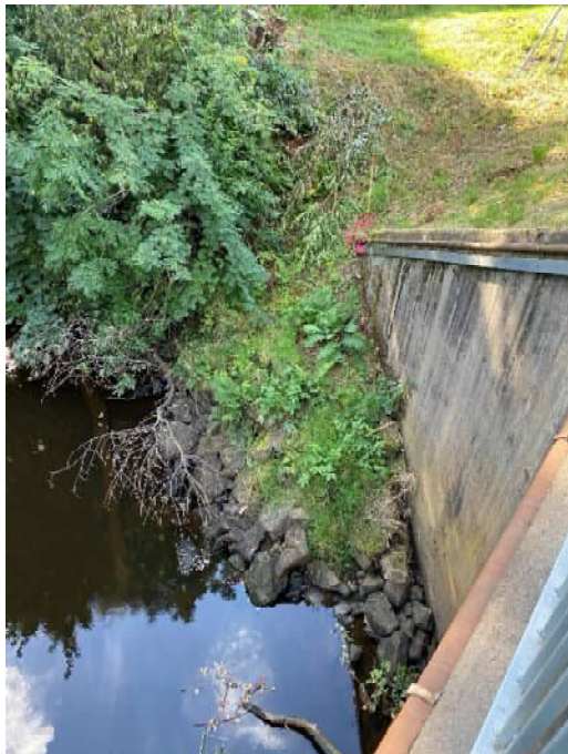
Figur 11, bro i väster, erosionsskydd.
