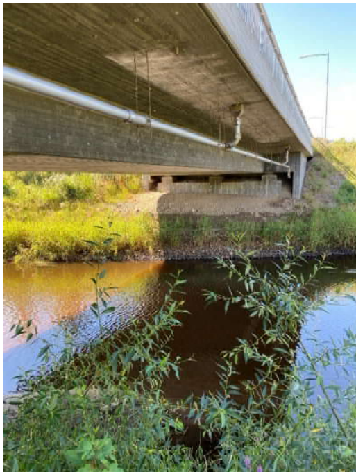
Figur 37, Erosionsskydd under bro (väst).
