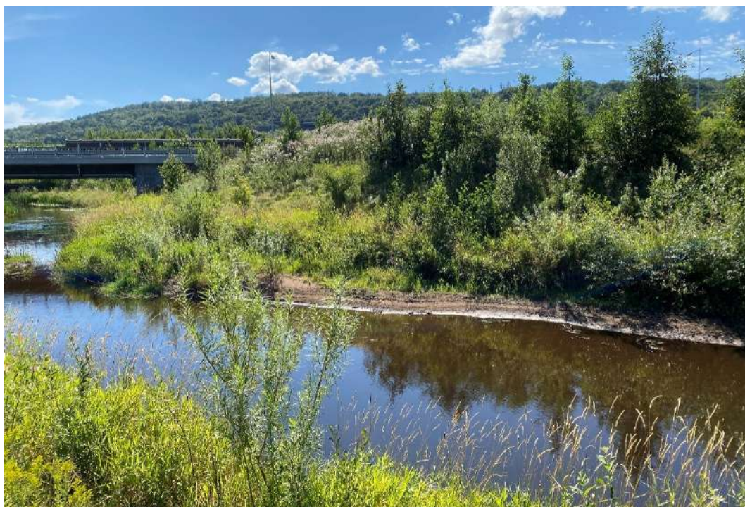
Figur 34, Vy omgrävd sträcka. Sedimentation grundar upp ån (vänster i bild). Strandparti utan erosionsskydd (höger i bild).
