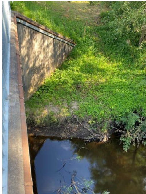
Figur 12, blottad jord i vattenlinje.
