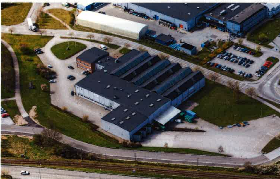
Bild 7. Planområdet och befintlig byggnad sett från östlig riktning.
