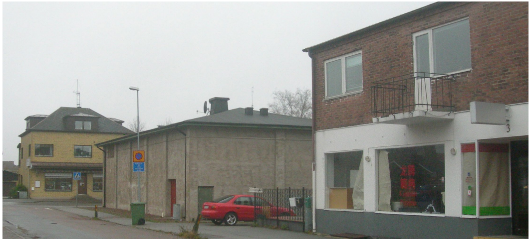
Vy över Brunnsgatan från sydost. Tvåvåningsbyggnaden på Brunnsgatan 3 till höger i bild. I bakgrunden Kulturhuset som har gatuadressen Svalegatan 22.
