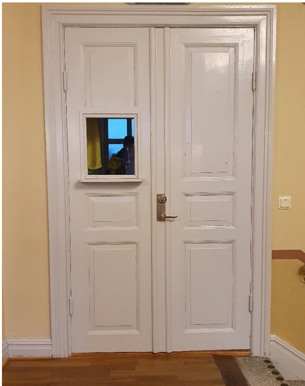
Originaldetaljer i det södra trapphuset; dörrfoder, sockellist, ledstång, klinkergolv i terrazzo, glasad innerdörr samt pardörr med lucka.
