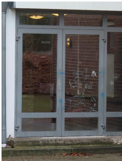
Glasdörrar från 1990-talet på gårdssidan.
