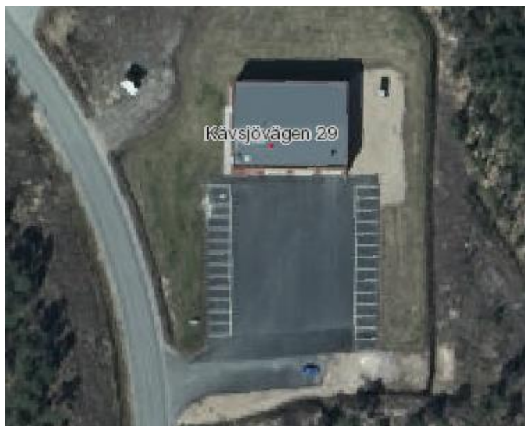
Räddningsstationen och tillhörande parkeringsyta 2
