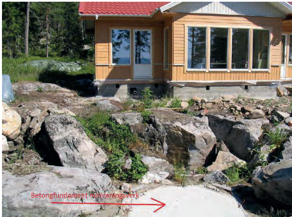
Bild 35. På grund av de besvärliga grundförhållandena i huvudsak berg så förlades minireningsverket i en naturlig bergavsats i ytterhörnet av 3:28.
