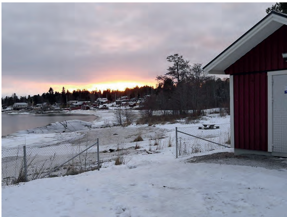
Bild 7. Bilden ovan visar vyn mot strandområdet genom den andra östra öppningen. Byggnaden i bilderna är pumpstationen. Foton tagna 2021-02-05.
