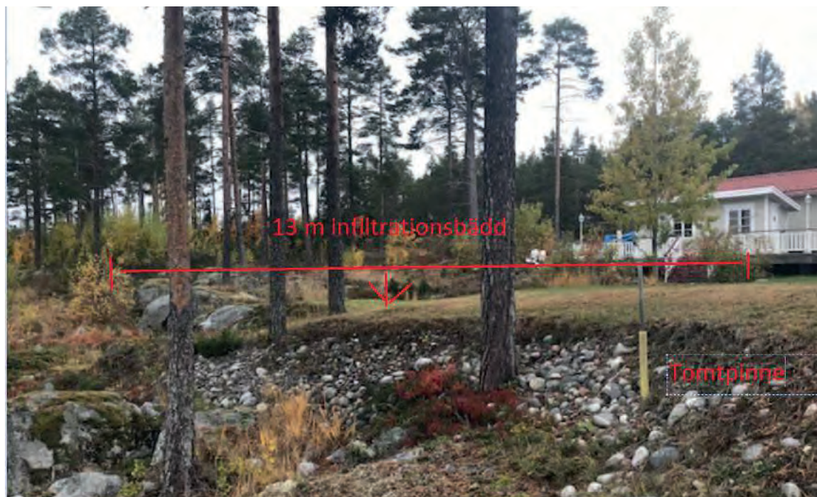
Bild 30. Infiltrationsbädd från minireningsverk varav ca 10m inom parkmarksområdet 2005
