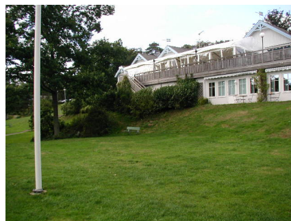
En tillbyggnad för bl a konferensverksamhet planeras på huvudanläggningens sydsida.
