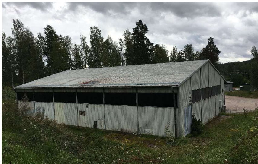
Den äldre plåtbyggnaden söder om planområdet
