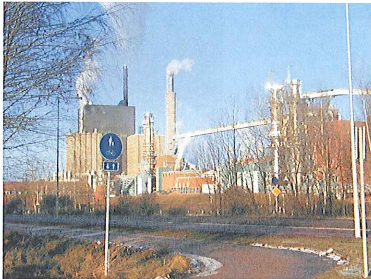
Stora Ensos massaindustri från Gävlevägen, riksväg 76
