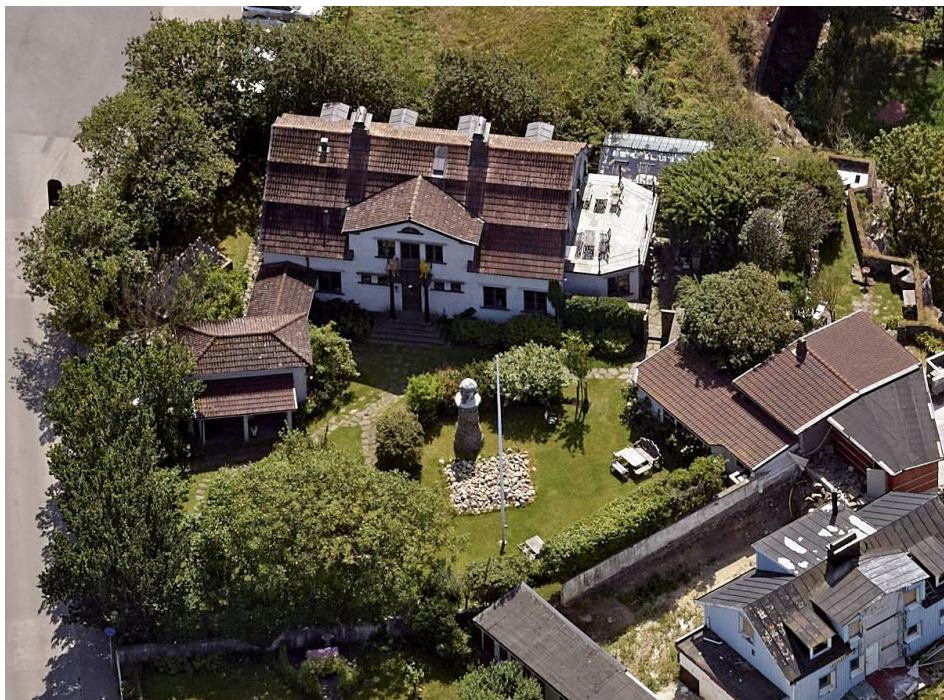
Snedbild över fastigheten Jungmannen 4 och dess befintliga byggnation.
