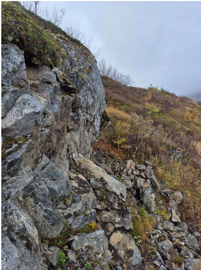
Figur 16. Berg i dagen och lösa block på Totthummeln's östra sida, i toppen av det potentiella utfallsområdet från GIS-analysen (foto Tyréns, 2024-10-04).
