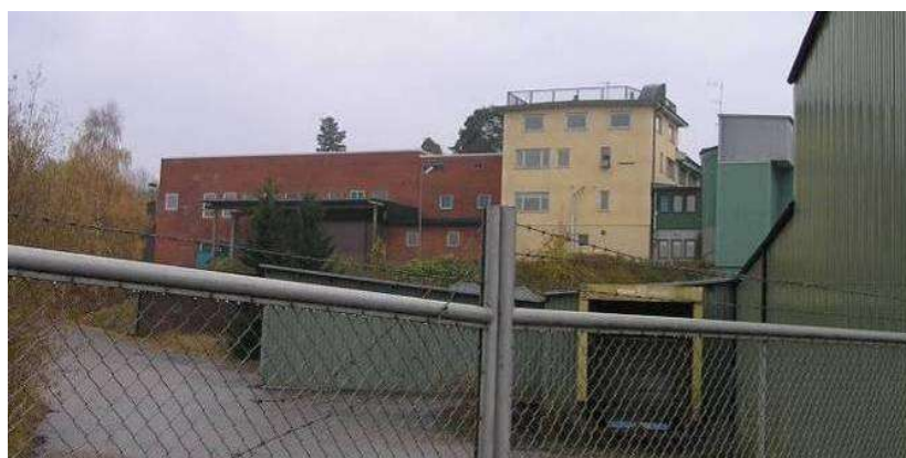
Några befintliga industribyggnader inom planområdet
