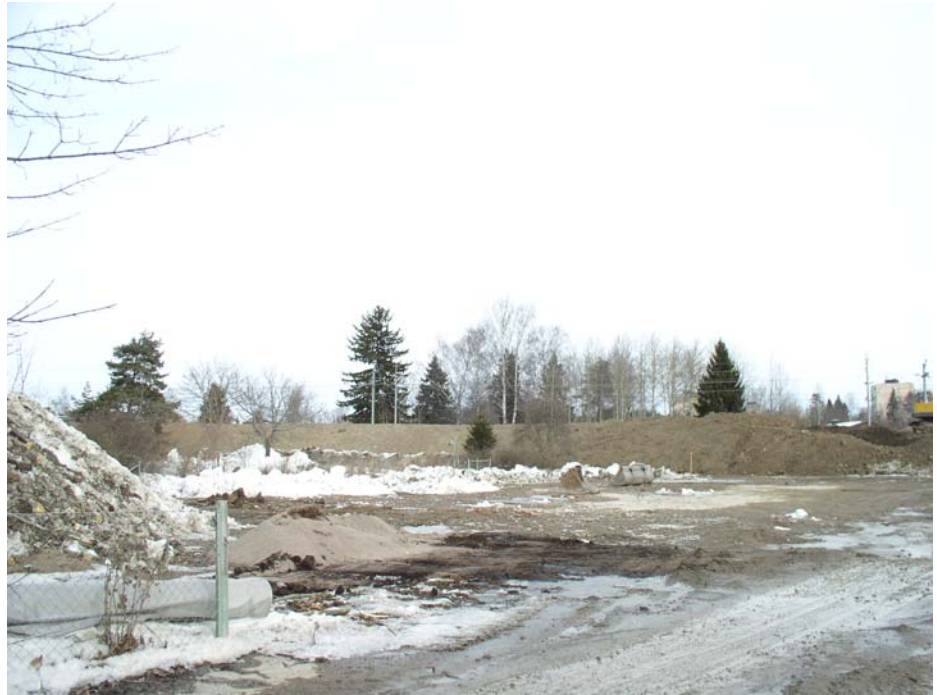
Bullervallen som är under byggnation.
