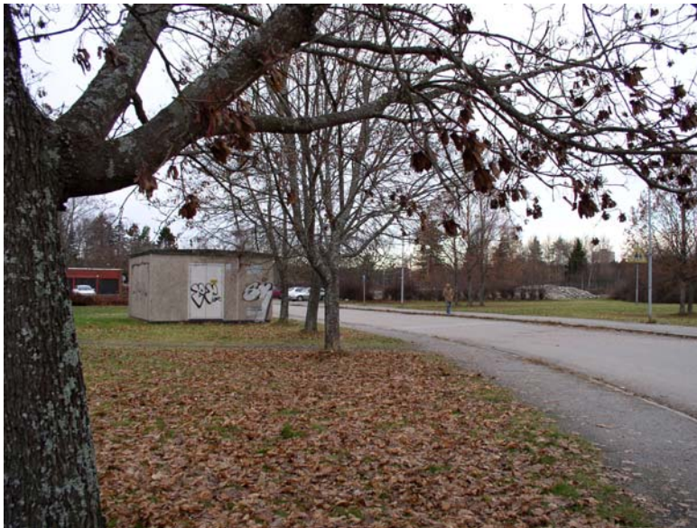
Befintlig transformatorstation utmed Fabriksgatan.
