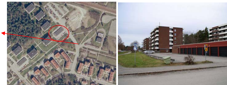
Flerbostadshus sydväst om Fabriksgatan med tillhörande garage.
