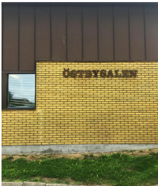
Figur 10. Typisk gestaltning av byggnaderna inom planområdet.
