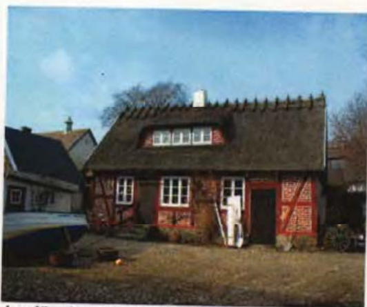
I nuläget q-märkt byggnad sedd från innergården
