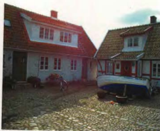
Putsad huvudbyggnad och sidobyggnad med falskt korsvirke.
