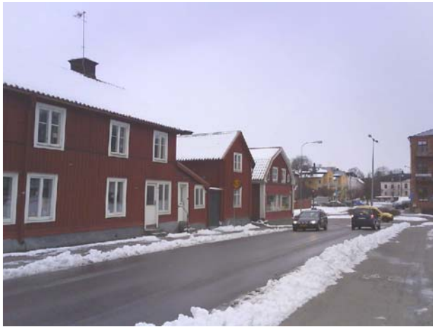
Fasaderna mot Hospitalsgatan
