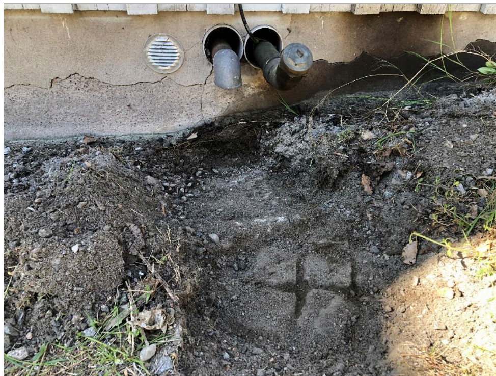
Figur 6. Vid PG3, påfyllning av oljecistern. Utanför den hårdgjorda kanten påträffas kullerstenar/knott.
