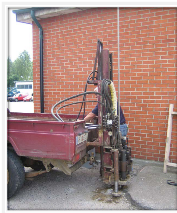
Foto 2. Provpunkt 17, ledningsgatans slut.
