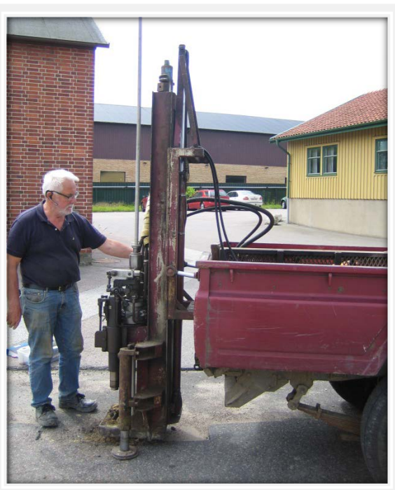
Foto 3. Provpunkt 20, mitt på ledningsgatan.
