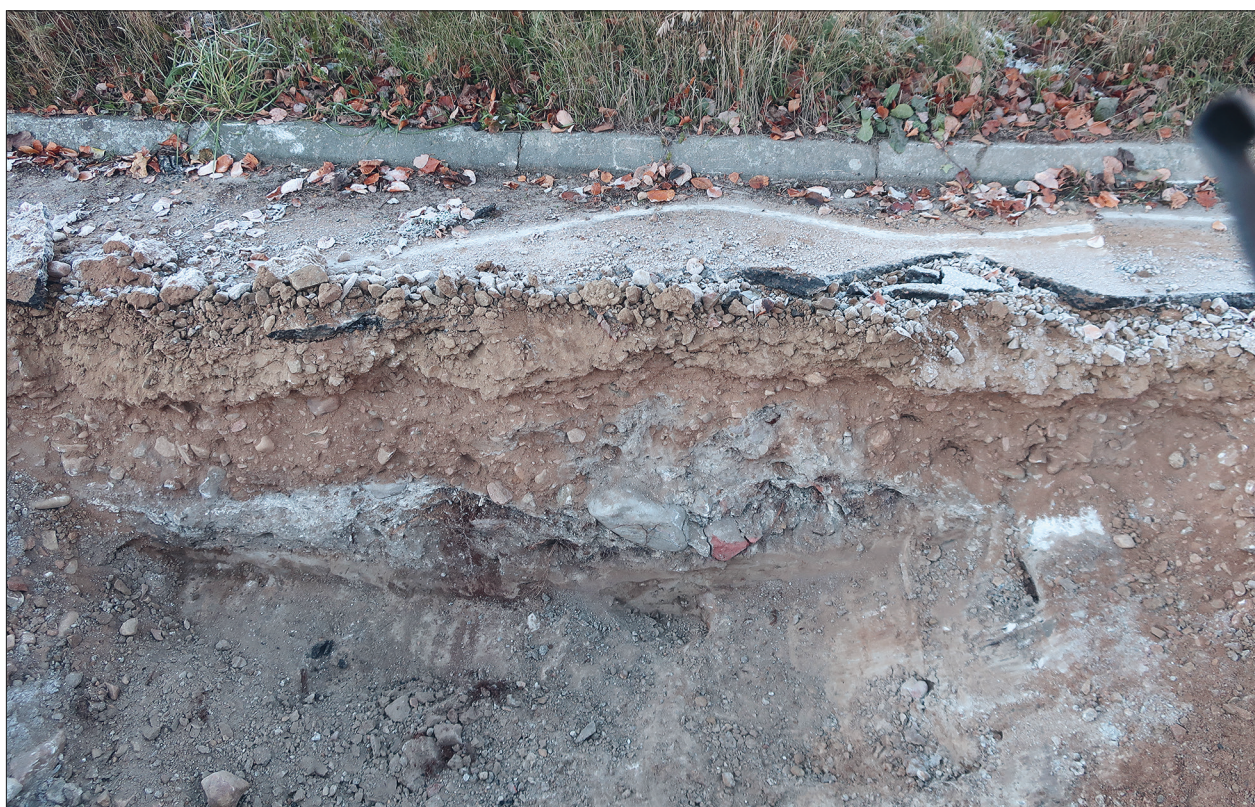
Figur 7. Profil i schakt 212 ut mot Pershögsgatan. Raseringslager under kraftiga bärlager. Foto från sydost: Mats Anglert.
