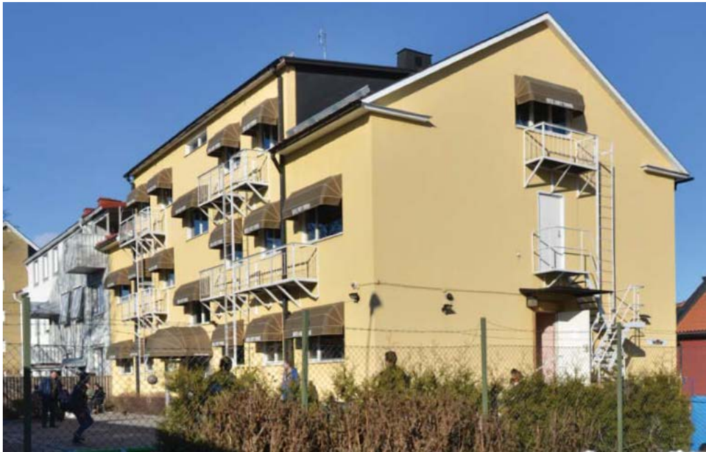
Huvudbyggnadens fasad mot gården.
