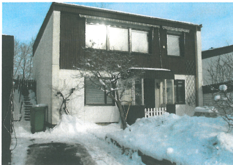
Kedjehus med färgsättning i originalutförande.
