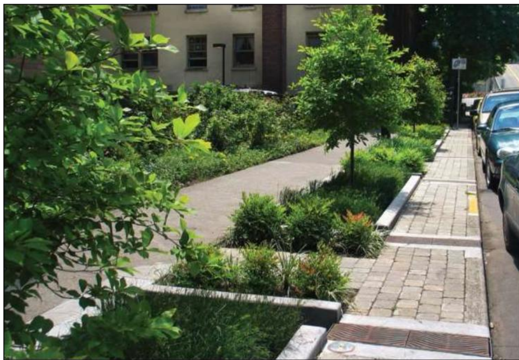
Figur 8 Exempel på nedsänkt växtbädd. Foto City of Portland
