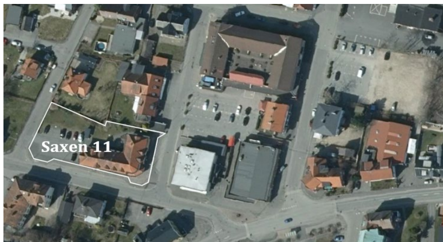
Bild som visar angränsande fastighet där det pågår en planändring.
