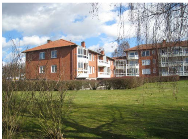
Trafikbuller på gården dämpas av de L-formade, befintliga byggnaderna mot omgivande gator.
