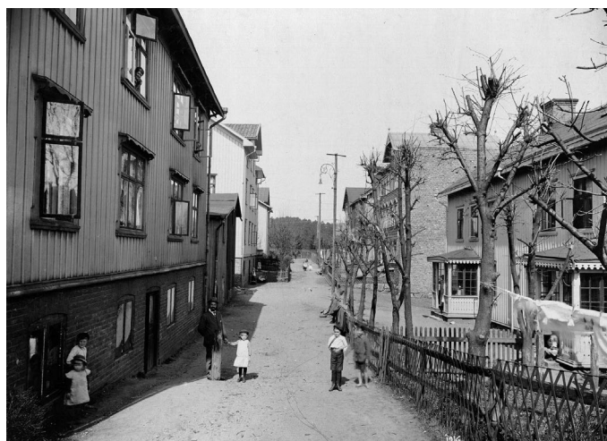
Sandemansgatan mot norr i planområdets nordvästra del år 1916.
