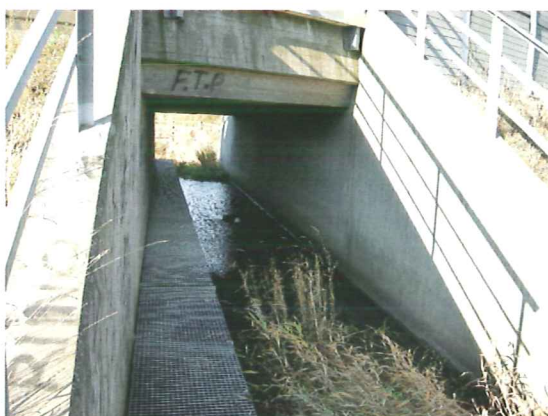
Vy in i gångtunneln
