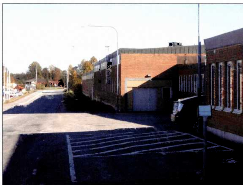
Befintliga förråds-/garagebyggnaden utmed Myrängsvägen. Foto: Martin Wernersson
