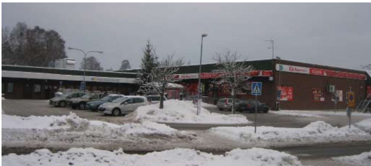
ICA-butiken till höger (byggnadens västra del). Entrén till källarvåningen ligger längst till höger i bilden.
