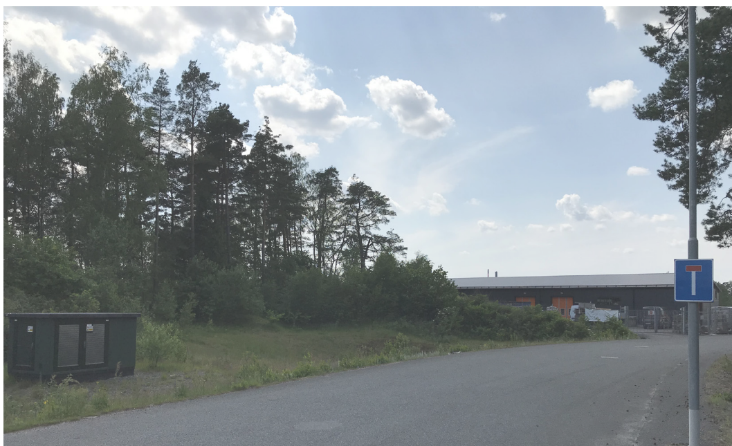
Vy av transformatorstation och dagvattenmagasin i södra delen av planområdet
