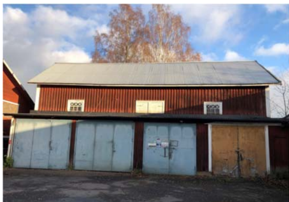
Garagebyggnad/ stall. Till höger framifrån med senare tillkommen garagetillbyggnad, men med spröjsade fönster samt stående lockläktspanel bakom tillbyggnaden. Till vänster, samma byggnad fast bakifrån med blottad timmerkonstruktion samt vita spröjsade fönster. Källa: Kulturmiljöutredning, Sweco.
