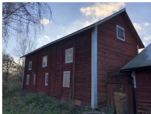
Garagebyggnad/ stall. Till höger framifrån med senare tillkommen garagetillbyggnad, men med spröjsade fönster samt stående lockläktspanel bakom tillbyggnaden. Till vänster, samma byggnad fast bakifrån med blottad timmerkonstruktion samt vita spröjsade fönster. Källa: Kulturmiljöutredning, Sweco.
