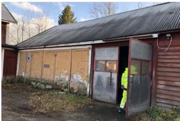
Garagebyggnad/ Verkstad. Byggnaden är kraftigt förvanskad i samband med ombyggnad till garage. Källa: Kulturmiljöutredning, Sweco
