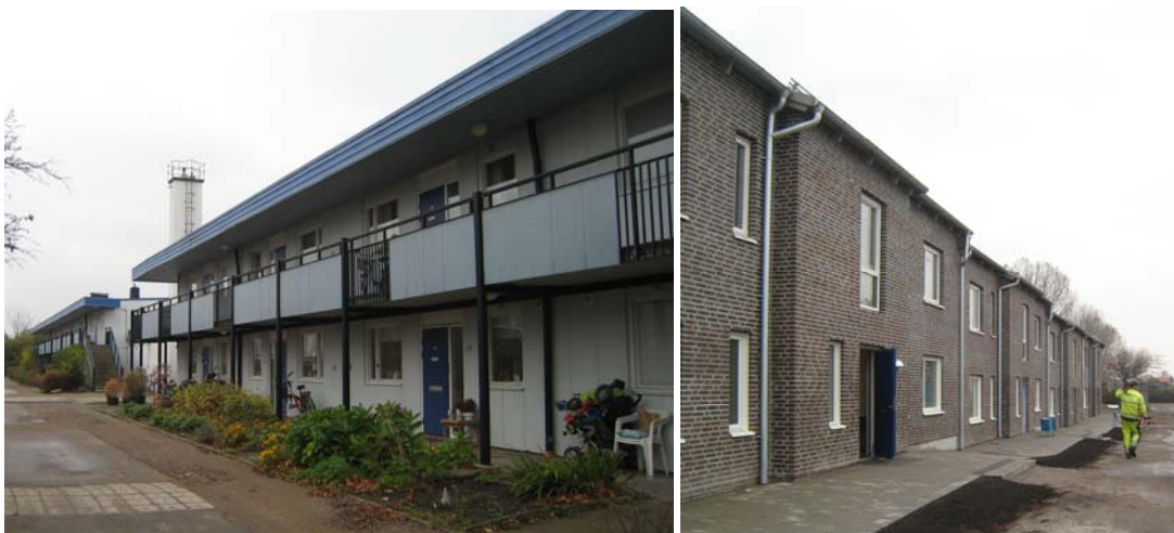
Befintlig bebyggelse. T.v. Äldre bebyggelse. T.h. Ny bebyggelse.
