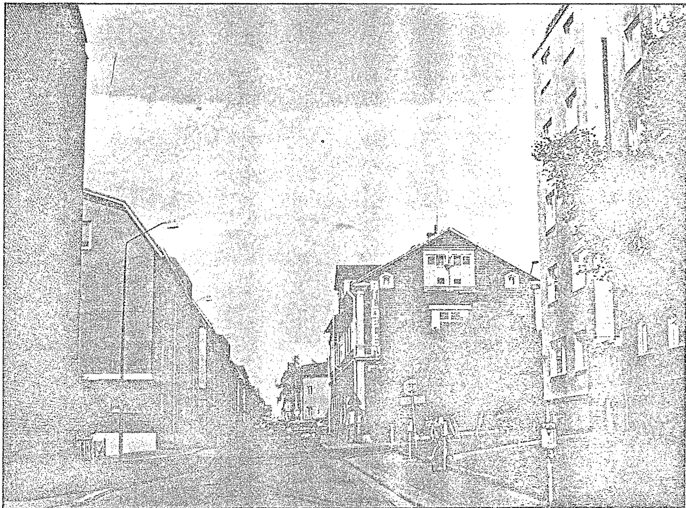
Kv Verkstaden (till höger-sett från söder)
