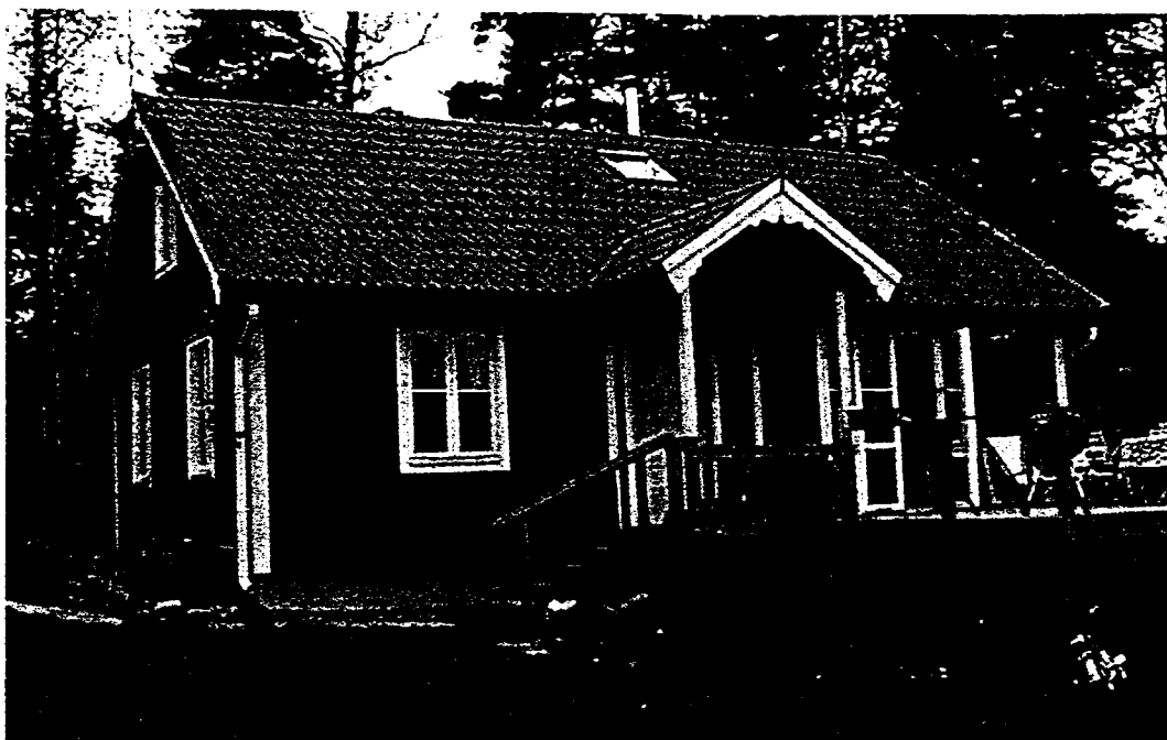
Huvudbyggnad på fastigheten BARNVIK 1:74
