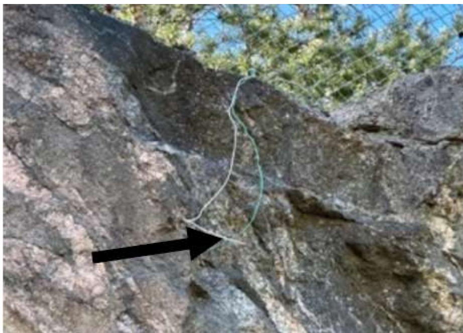
Bilden visar exempel från planområdet, där pil visar mot kablar från sprängning.
