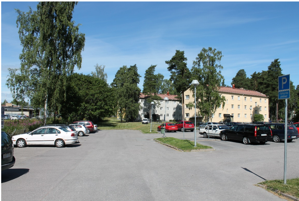
Befintlig parkering väster om St Torgils väg.
